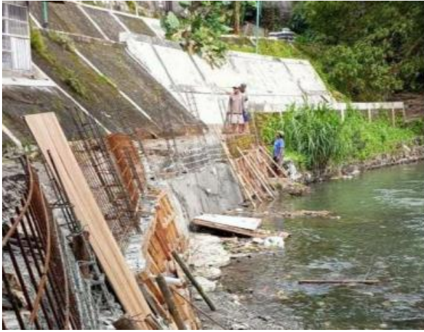
Perbaikan Talud Kricak
