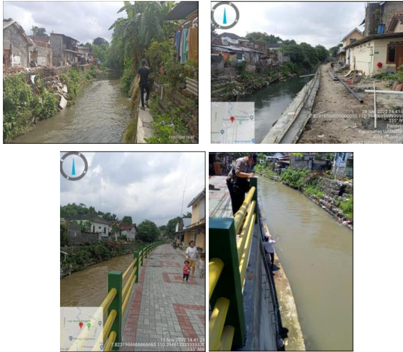
Penataan Kawasan Kampung Karang Prenggan Kotagede, kondisi 0%, 50% dan 100%
